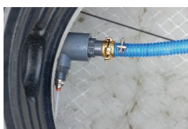
Fig-20 : raccordement côté réacteur biologique
