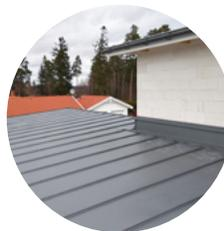
Les **toitures métalliques** sont de fausses amies. Les pluies acides agissent sur le cuivre ou l'aluminium qui libèrent des métaux lourds dans l'eau. Une situation non souhaitable. Le zinc est quant à lui parfait en toiture pour l'eau de pluie.
