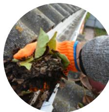
Une fois arrivée sur le toit, l'eau de pluie se mélange à divers éléments : feuilles, branches, plumes et fientes d'oiseaux ou encore particules polluantes. Pour empêcher ces éléments d'arriver dans ma cuve, j'ai placé du grillage sur mes gouttières pour éviter qu'elles ne se bouchent. Une grille inclinée aurait également pu être une bonne solution.
