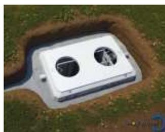
Fig-15 : Remblaiement
