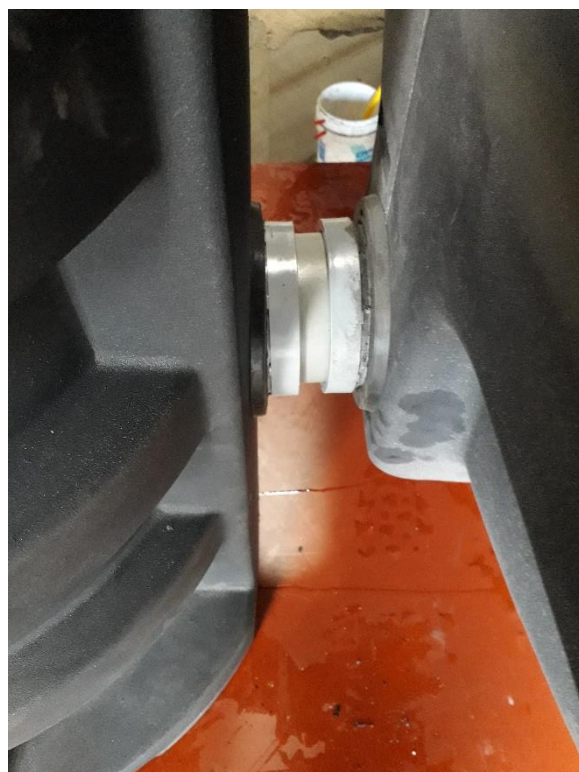
Fig.8 – raccordement du relevage au filtre compact x-perco® R-90 monobloc
