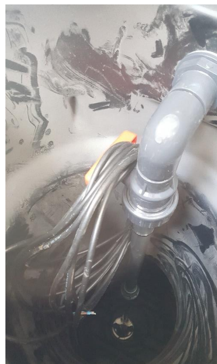
Fig. 25 – fermeture du poste de relevage
