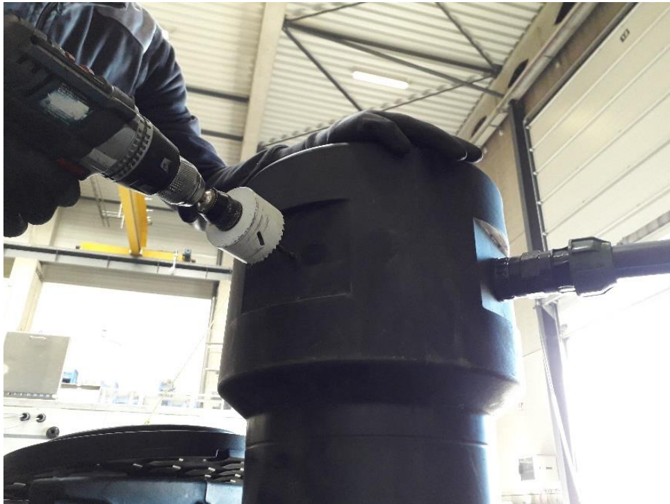
Fig. 20 – placement de la gaine de protection (1)
