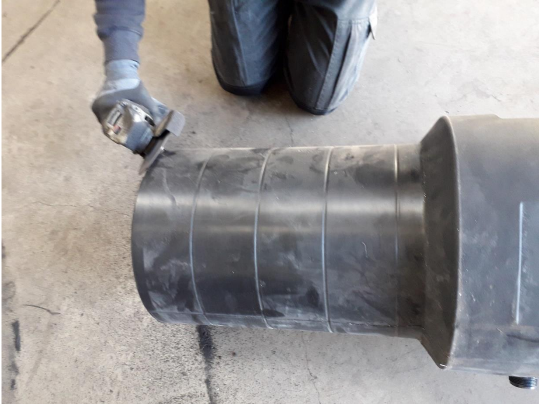
Fig.17 – chanfreinage de la rehausse
