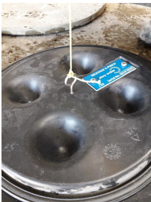
Fig. 21 – corde à l'extrémité de l'œillet du tampon
