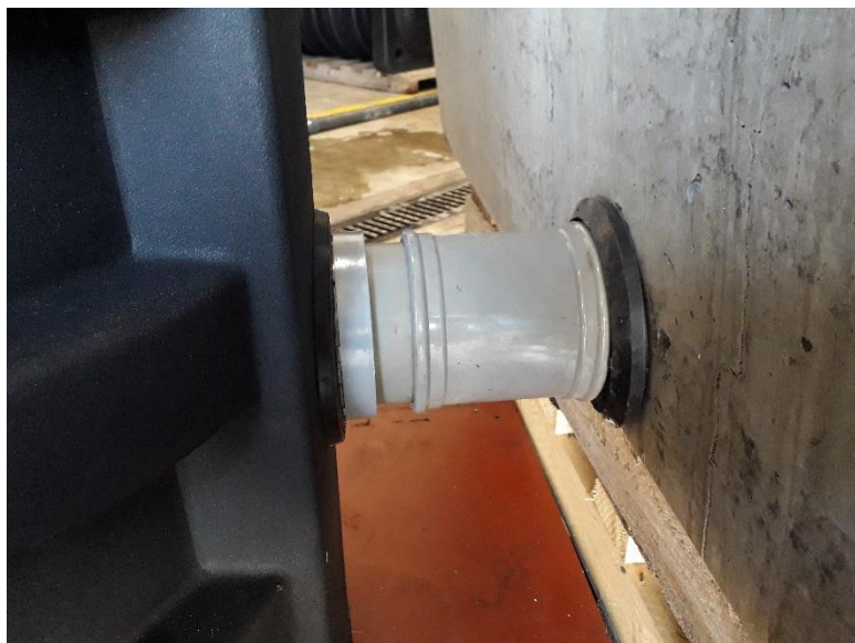
Fig. 7 – raccordement du relevage au filtre compact x-perco® C-90 5 EH
