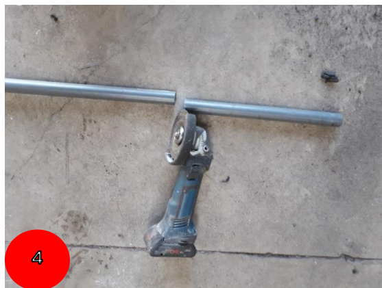
Fig. 24 – tuyauterie coupée et chanfreinée
