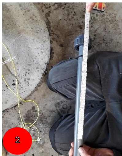
Fig. 23 – Recoupe à longueur de la tuyauterie
