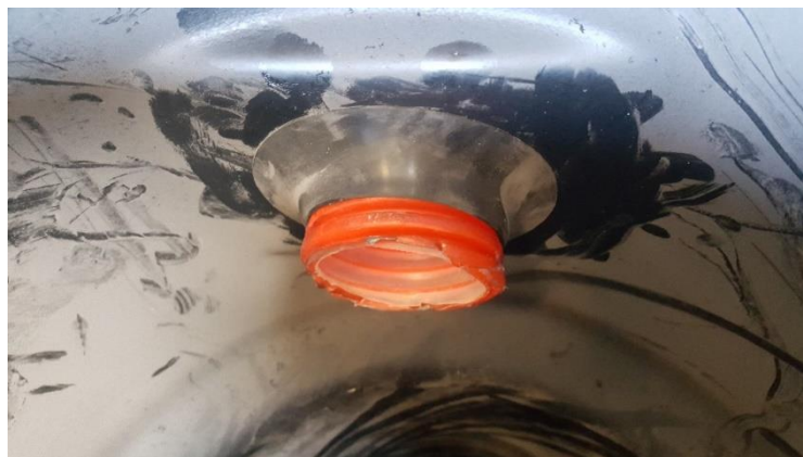
Fig. 29– placement de la gaine de protection
