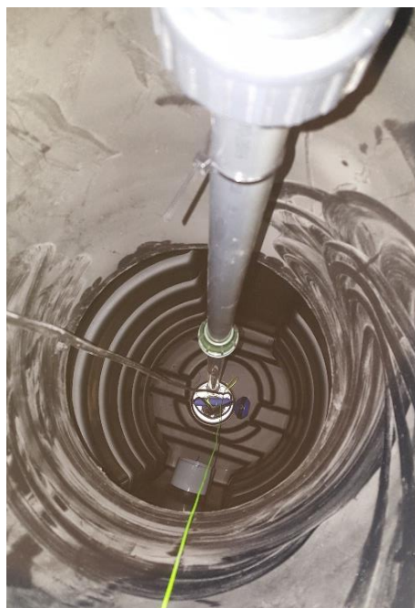
Fig. 22 – descente de la pompe dans le poste de relevage
