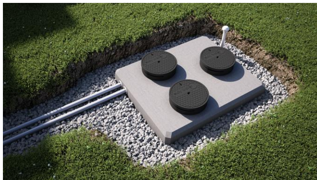
Fig-20 : Exemple de remblaiement
