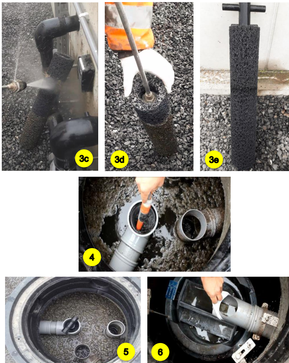
Fig-14 : Etapes de la procédure de nettoyage des préfiltres
