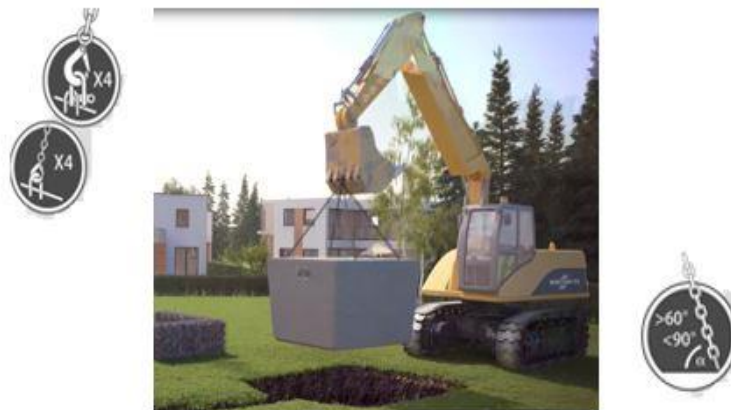
Fig-19 : Manutention de cuve
