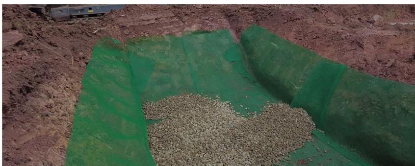
*Fouille avec géogrille installée*
