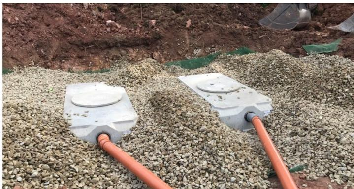
*Remblai au gravier jusqu'à l'épaule des infiltror®s C-90*
