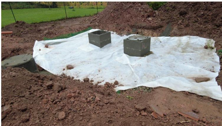
*Pose du géotextile sur 2 infiltra®s C-90 avec rehausse béton*
