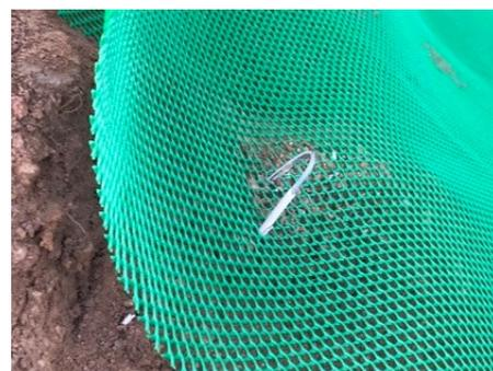
*Exemple de crochet de fixation*
