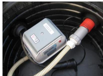
Fig-23 : Raccordement électrique du surpresseur en local technique
