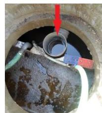
Fig 6a : Té d'échantillonnage dans une station Oxyfix® 5 EH
