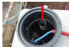
Fig 6b : Té d'échantillonnage dans une station Oxyfix® 9 ou 17EH
