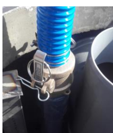
Fig-21 : Raccordement côté réacteur biologique (38EH MB)
