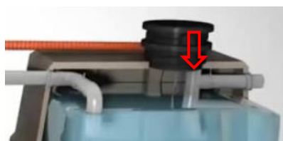
Fig 5b : Té d'échantillonnage dans une station Oxyfix® 38, 58, 75 ou 99EH
