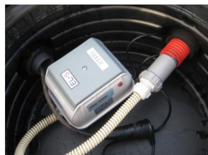
Fig-29 : Raccordement électrique du surpresseur en local technique
