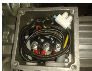
Fig-31 : Exemple de montage pour un moteur triphasé 3x380
