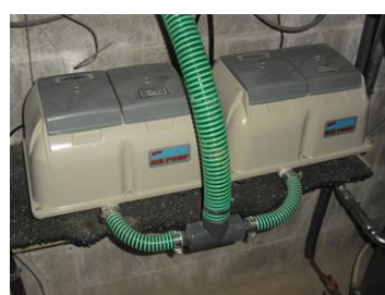
Fig-22 : Raccordement côté surpresseur (38EH MB)
