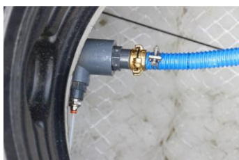
Fig-19 : Raccordement côté réacteur biologique (27EH)
