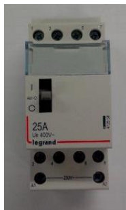
Fig-33: Contacteur moteur avec sélecteur « I-AUTO-0 »
