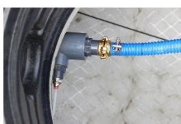
Fig-11 : raccordement côté réacteur biologique
