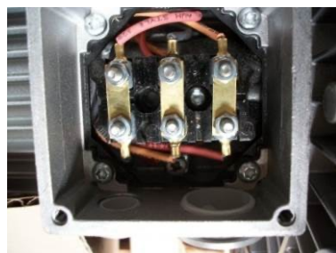
Fig-22 : montage «Triangle» 3 x 220V Δ
