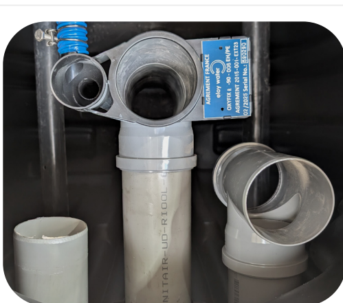
Fig-12 : option 2 – dans ce cas, intervertir le Té de ventilation, bouchon à gauche
