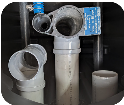
Fig-11 : option 1 – position Té de ventilation sortie d'usine, bouchon à droite
